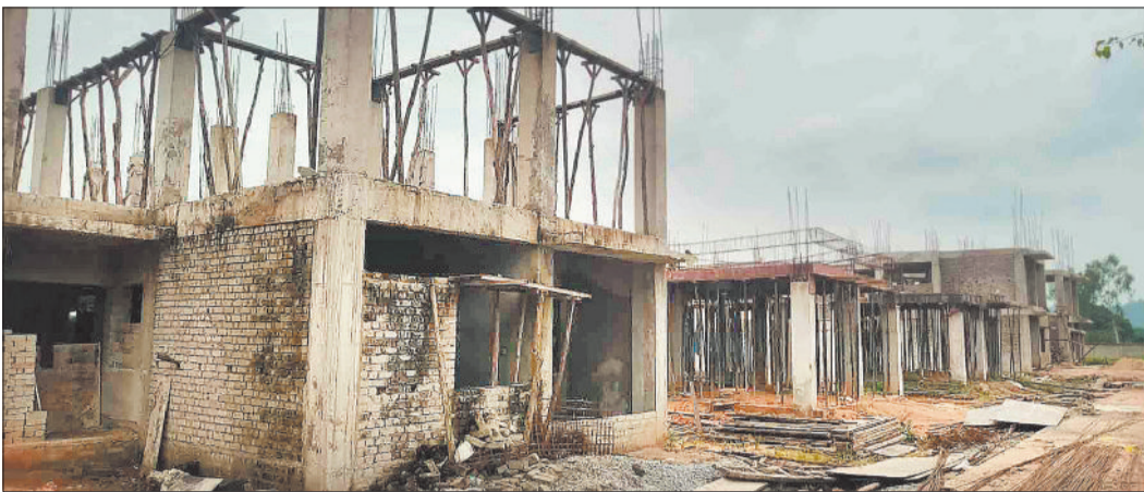
निर्माणीन स्कूल व छात्रावास भवन।
